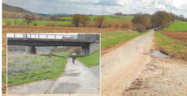
Der Radweg zwischen THW und Flussbegegnungspunkt (kleines Bild) soll noch in diesem Jahr erneuert werden. Auch im Asseler Feld gibt es Arbeiten. Foto: Jürgen Vahle
